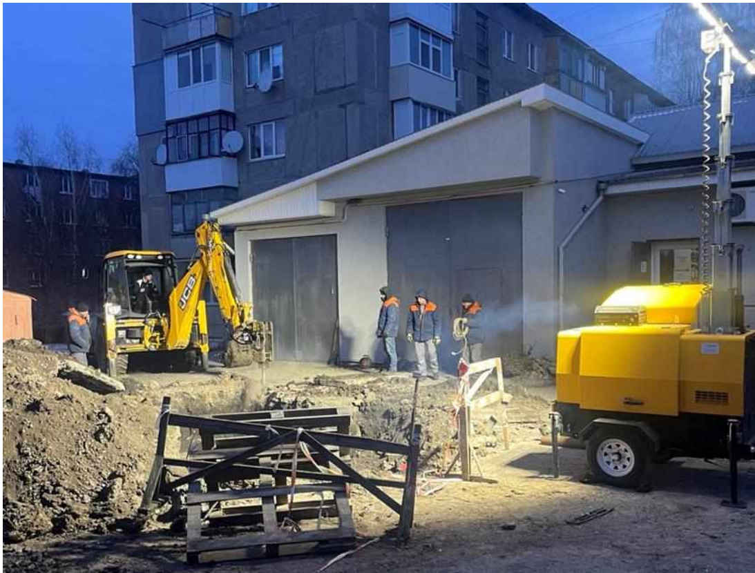
Фото. Усування пориву теплової мережі 27.12.2025 вул. Наріжного 32
