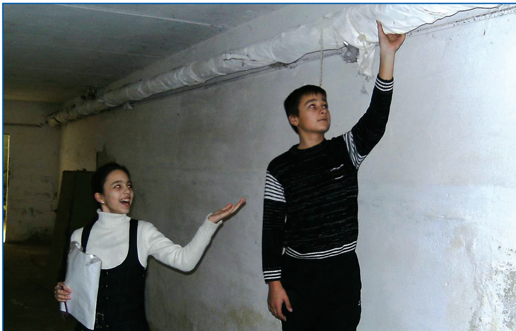
Перевірка надійності теплової ізоляції. Школа №14-ліцей, м. Євпаторія.
