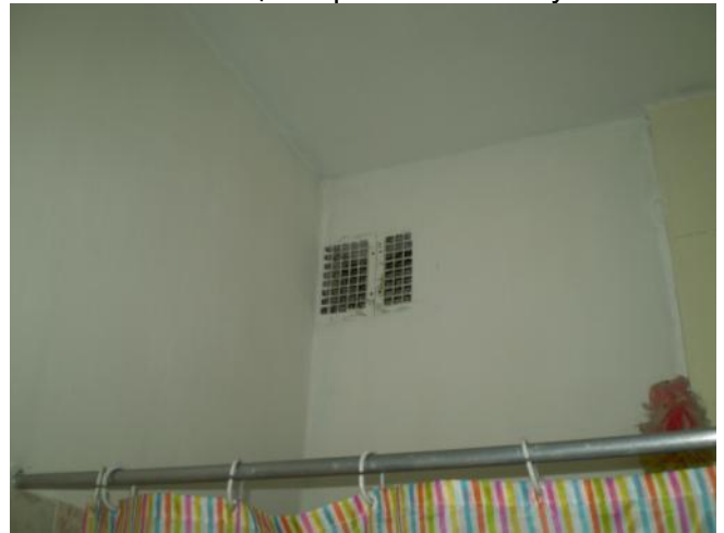
Вентиляційна решітка в санвузлі
