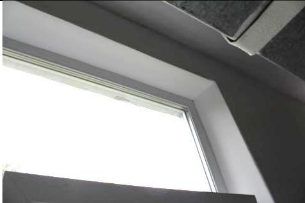
Зразок облаштування внутрішніх відкосів
