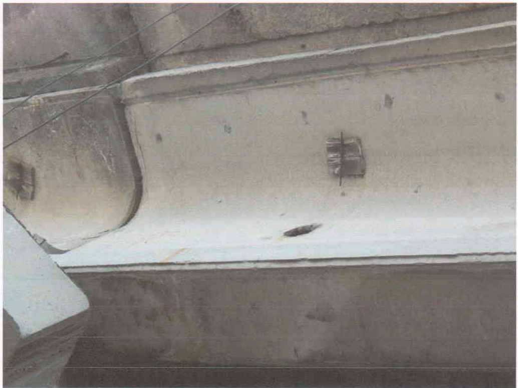
Рис. В.1.32 – Балка А в осі 4, вид К-А
