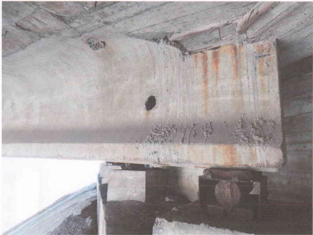
Рис. В.1.9 – Каткова опора по осям 1-2, балка Д, вид А-К
