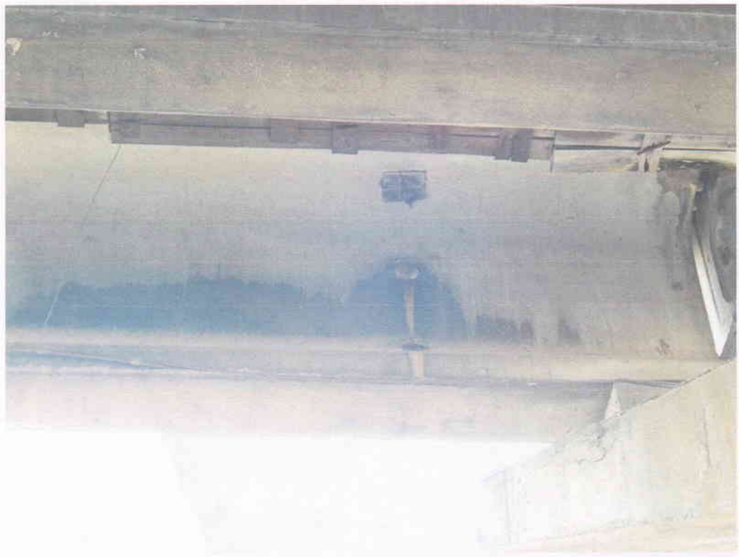
Рис. В.147 – Балка К в осі 5, вид К-А
