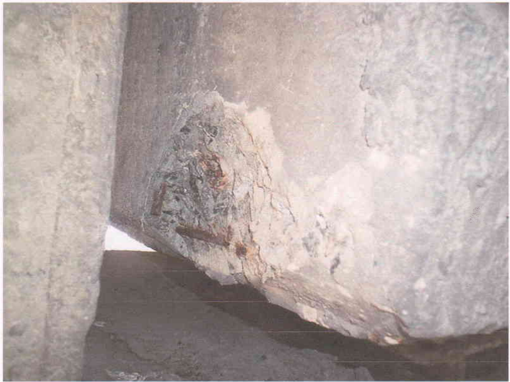
Рис. В.1.31 – Балка Ж в осі 3, вид К-А
