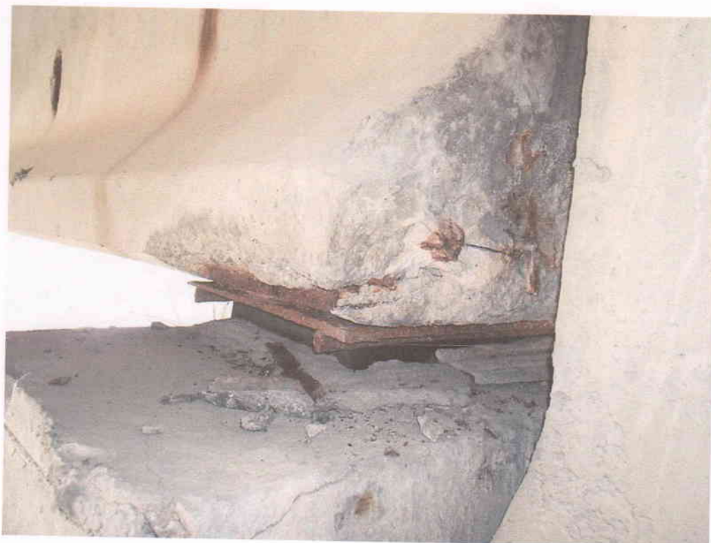
Рис. В.1.28 - Балка А в осі 3, вид К-А
