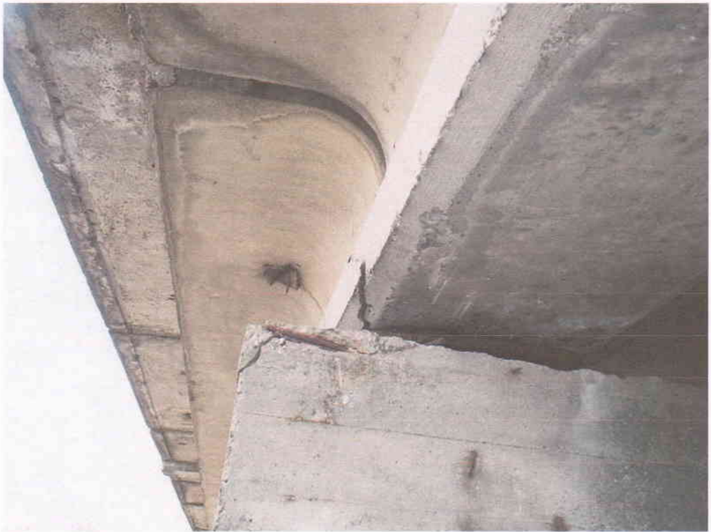
Рис. В.149 - Балка А в осі 5-6, вид А-К
