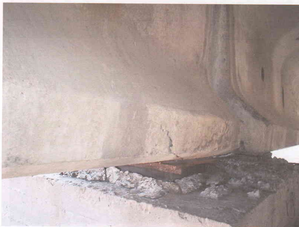
Рис. В.1.30 - Балка Ж в осі 3, вид К-А
