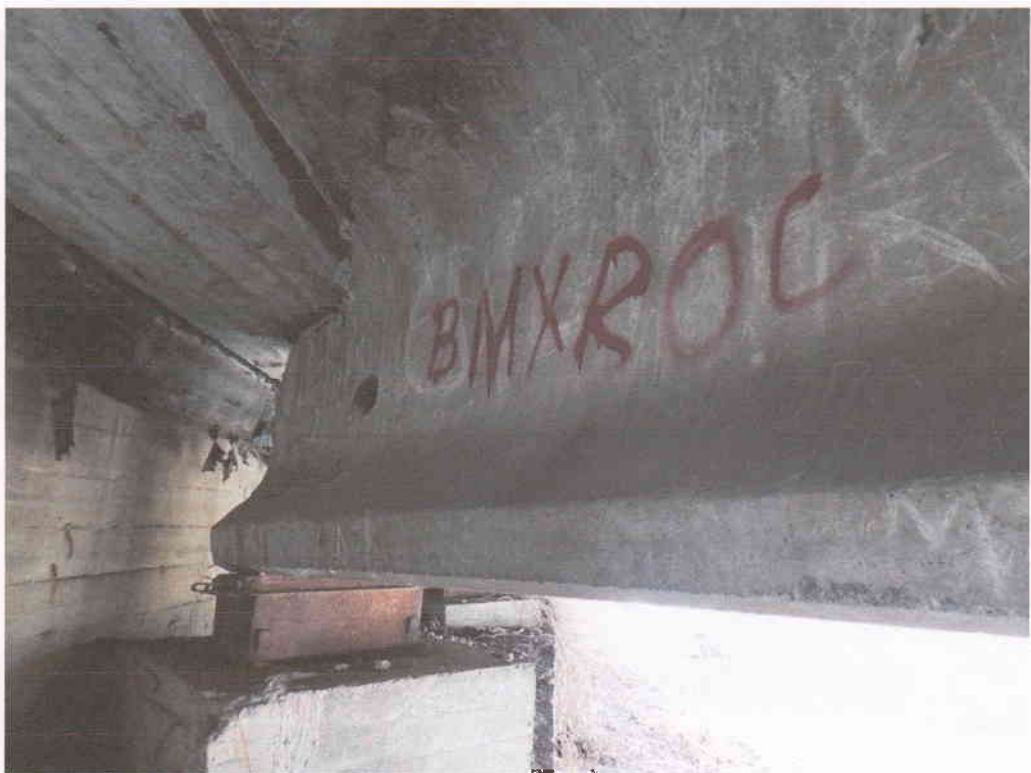
Рис. В.1.10 – Каткова опора, балка Е в осях 1-2, вид А-К
