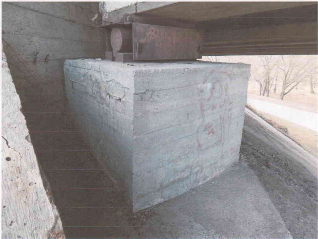
Рис. В.1.3 – Каткова опора по осям 1-2, балка А, вид А-К
