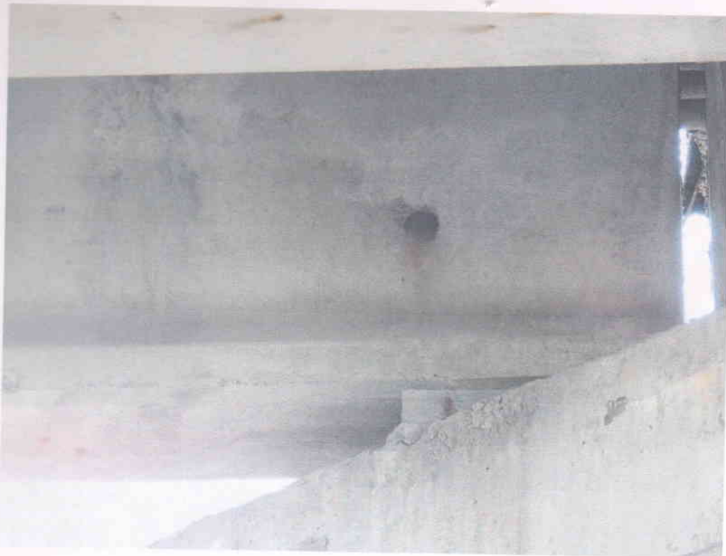
Рис. В.1.27 - Балка К в осі 3, вид К-А
