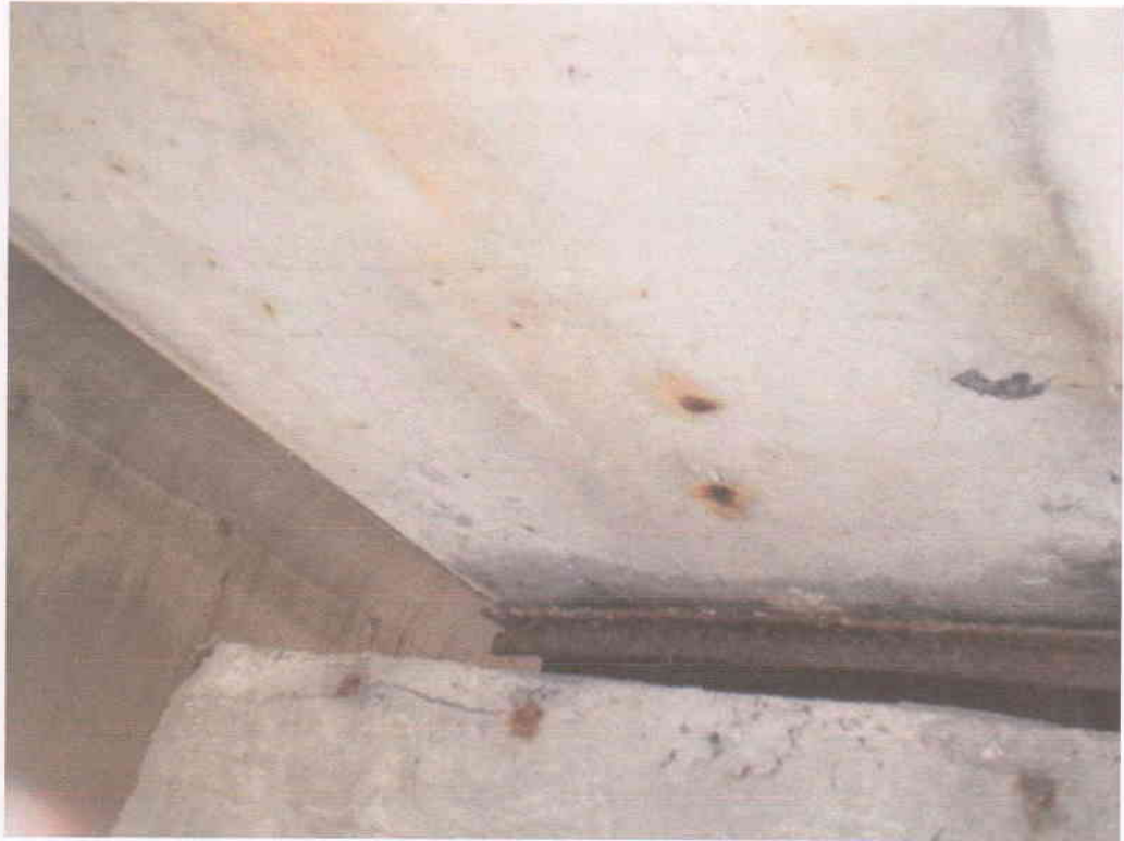
Рис. В.1.51 – Балка К в осі 5-6, вид А-К
