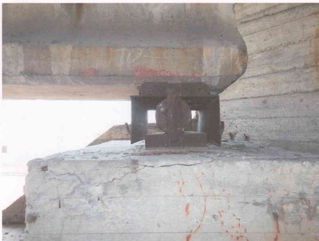
Рис. В.1.5 – Каткова опора по осям 1-2, балка А, вид А-К
