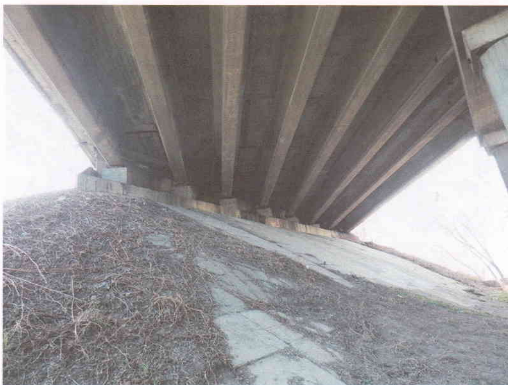
Рис. В.1.75 – Загальний вид осі 1-2, вид А-К
