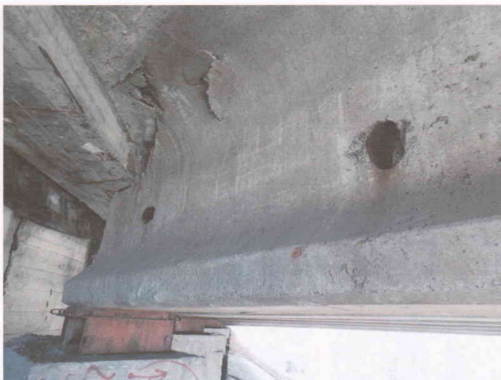
Рис. В.1.6 – Каткова опора по осям 1-2, балка Б, вид А-К
