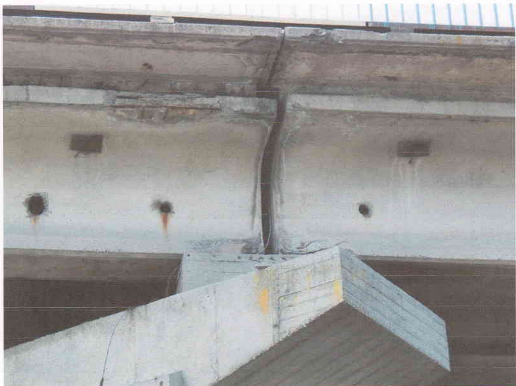
Рис. В.1.20 – Балка А в осі 3, вид К-А
