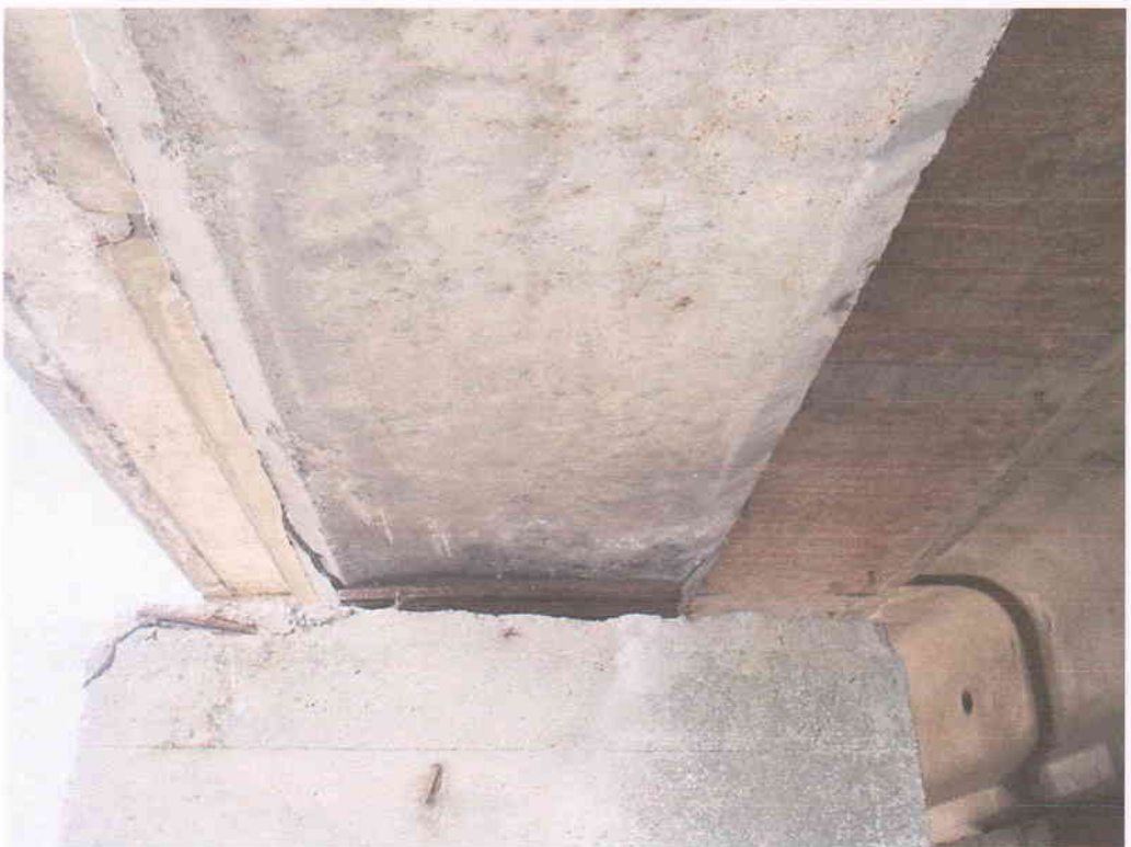
Рис. В.150 - Балка А в осі 5-6, вид А-К
