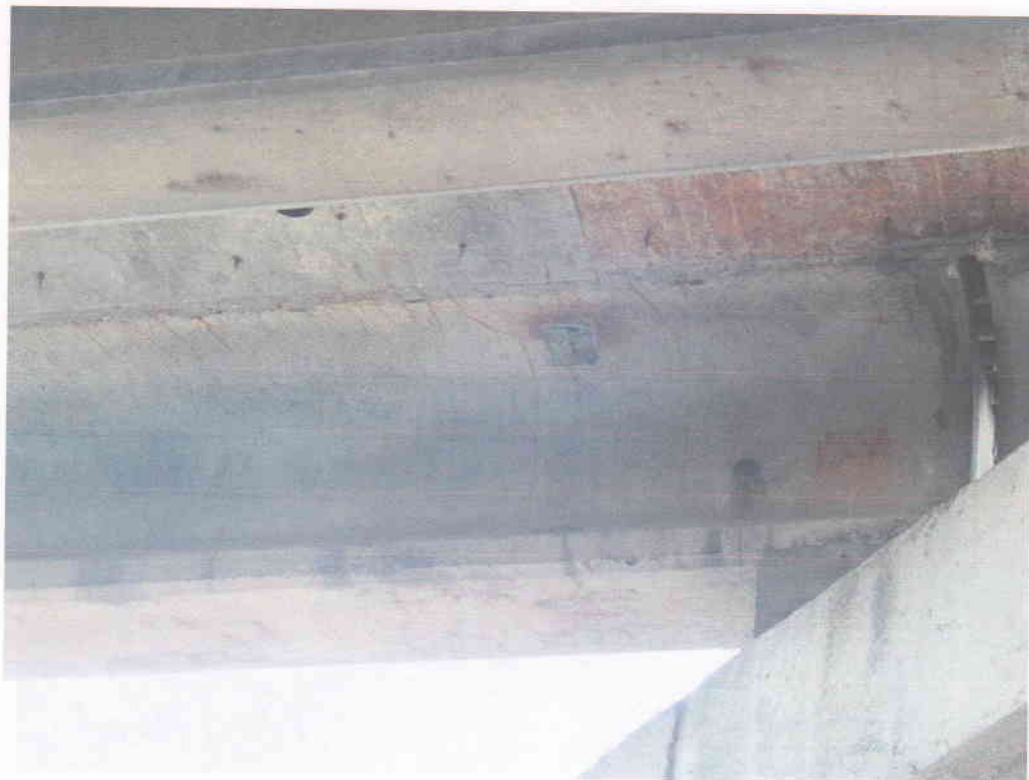
Рис. В.159 - Балка К в осі 6, вид К-А
