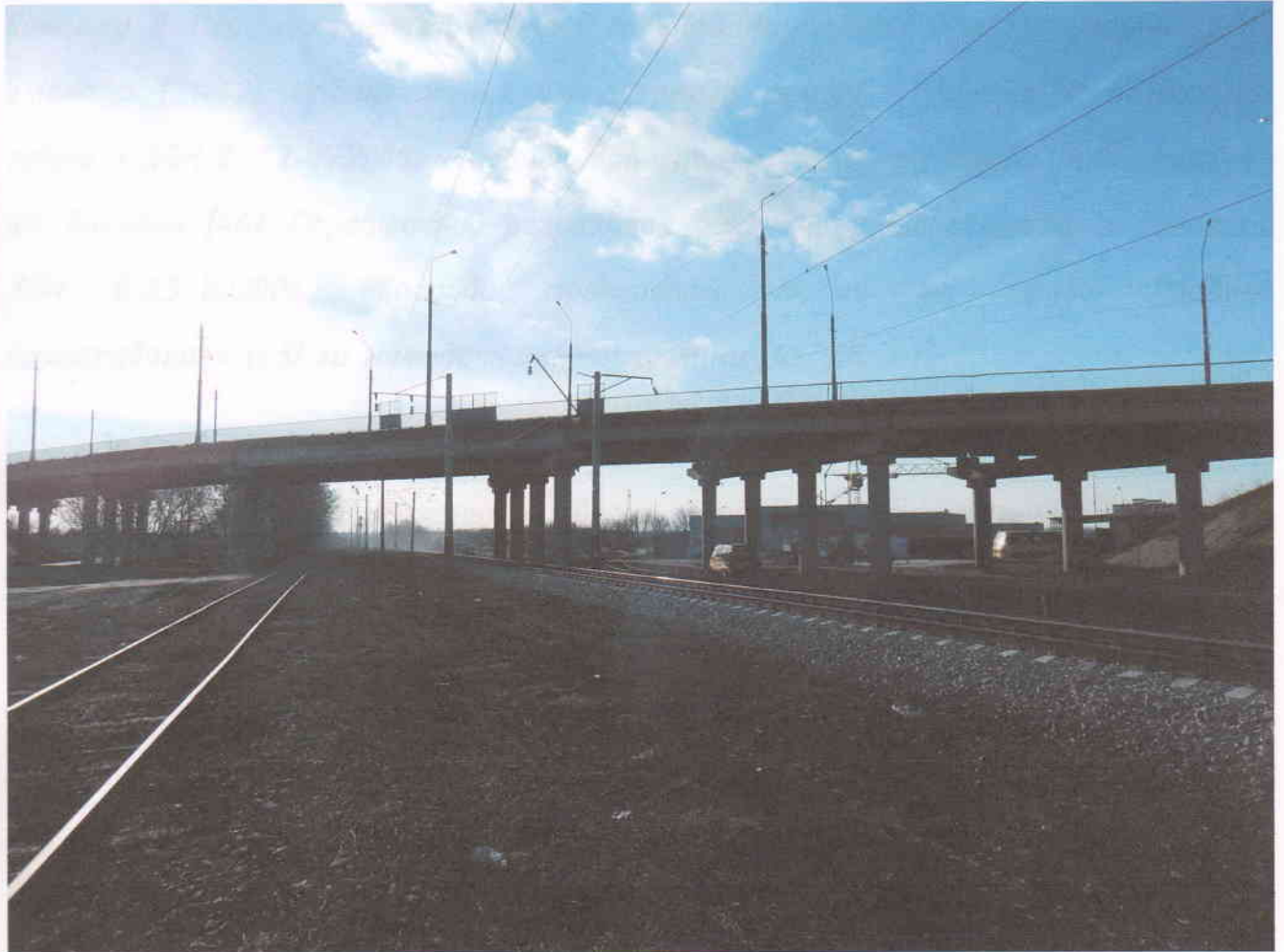
Рис. 3.1 - Загальний вид шляхопроводу в осях 1-8
