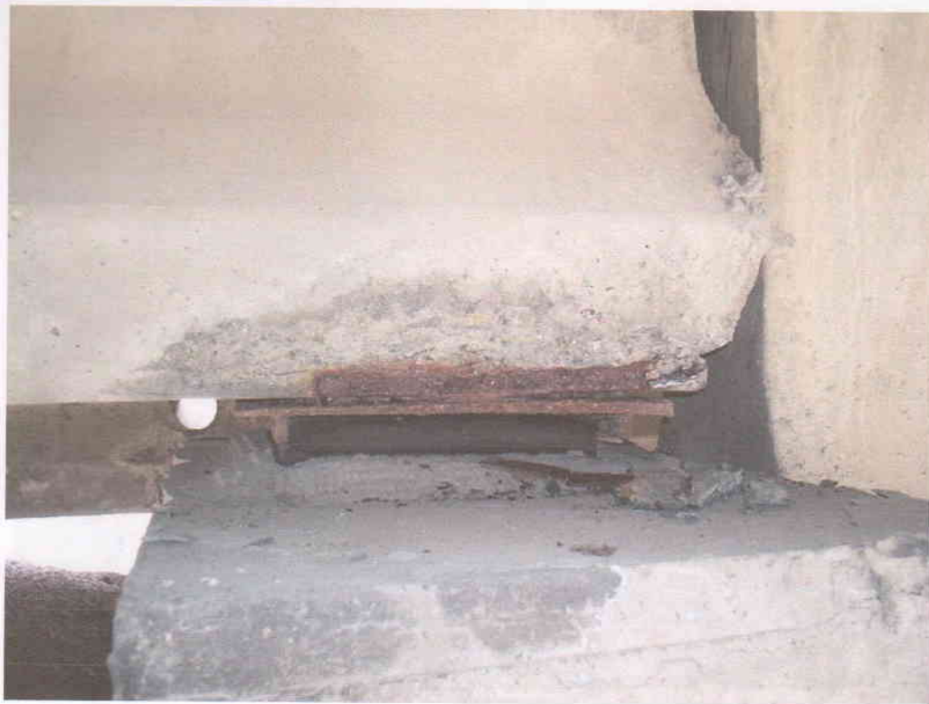
Рис. В.1.29 - Каткова опора, балка А в осі 3, вид К-А
