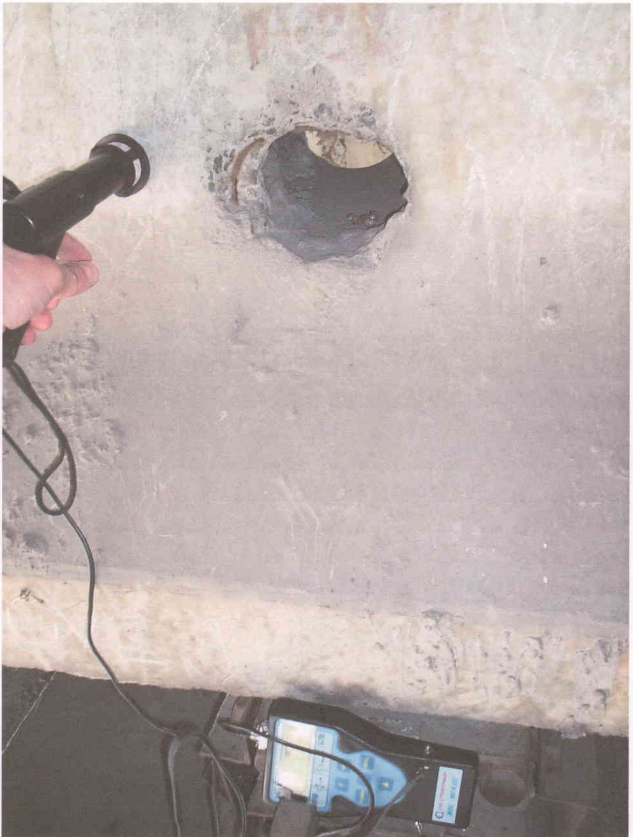
Рис. 2.1 – Визначення міцності бетону неруйнівним методом ударного імпульсу з використанням універсального вимірювача міцності будівельних матеріалів (склерометра) "ИПС-МГ4.03"
