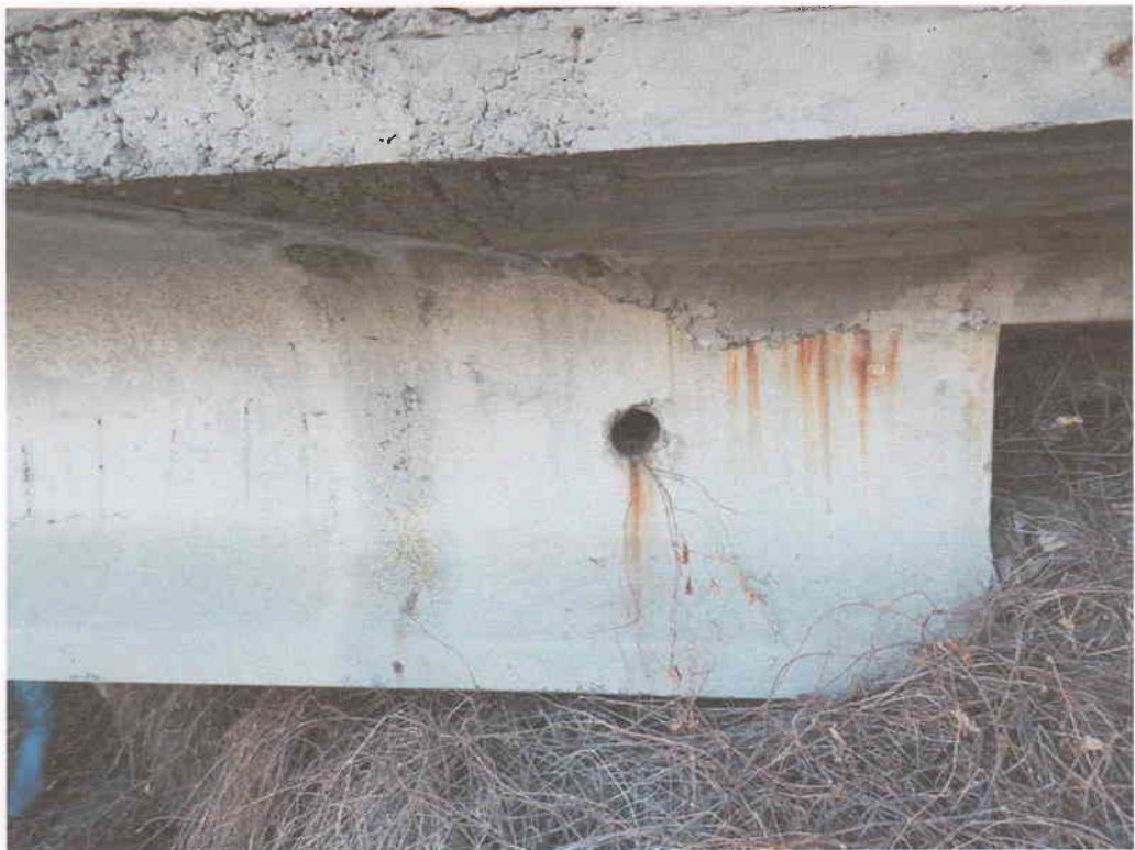
Рис. В.1.67 – Балка А в осі 8, вид К-А
