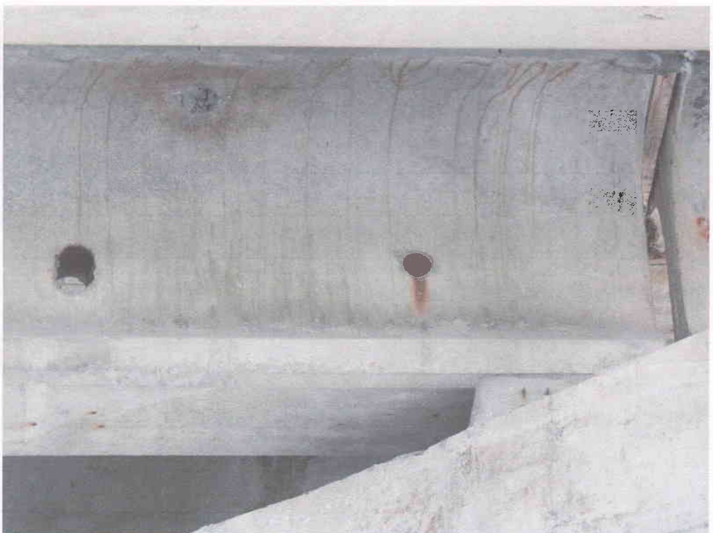
Рис. В.1.26 - Балка Ж в осі 3, вид К-А
