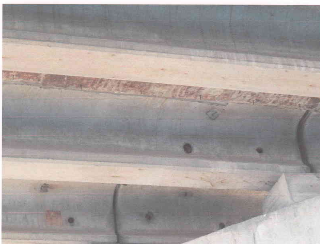
Рис. В.1.64 – Балка Д в осі 7, вид К-А
