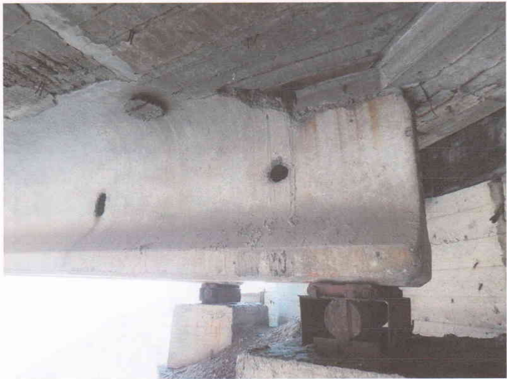
Рис. В.1.7 – Каткова опора по осям 1-2, балка В, вид А-К
