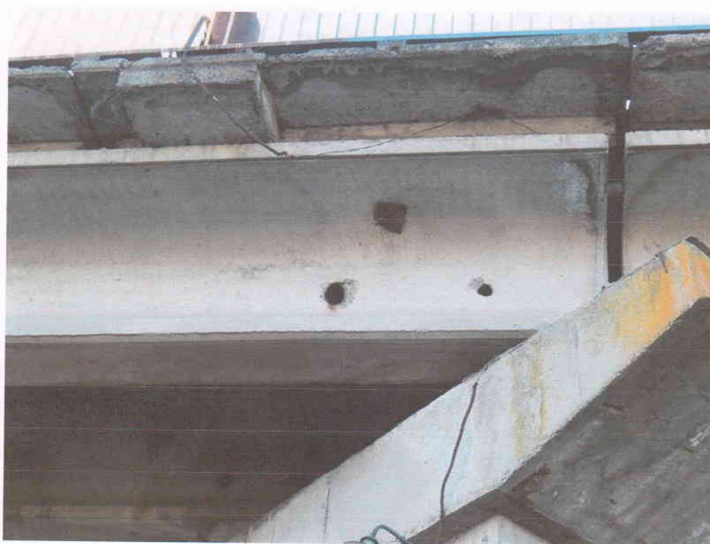
Рис. В.160 - Балка А в осі 7, вид К-А
