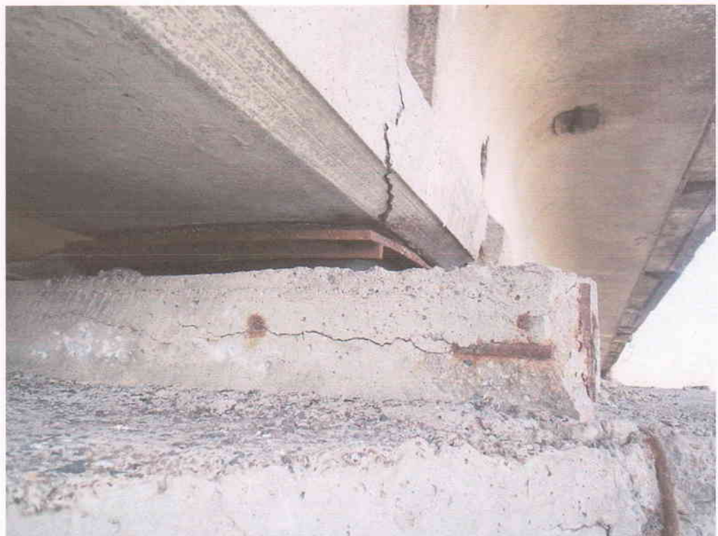
Рис. В.148 – Балка А в осі 5-6, вид К-А
