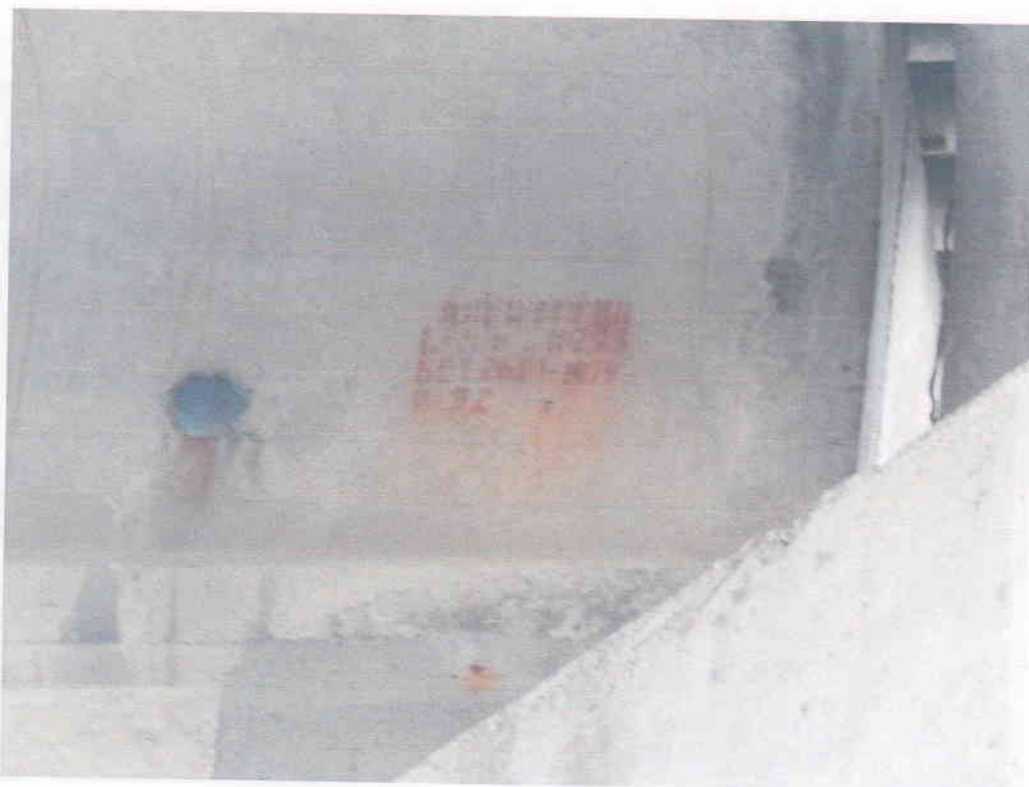
Рис. В.1.58 - Балка Ж в осі 6, вид К-А
