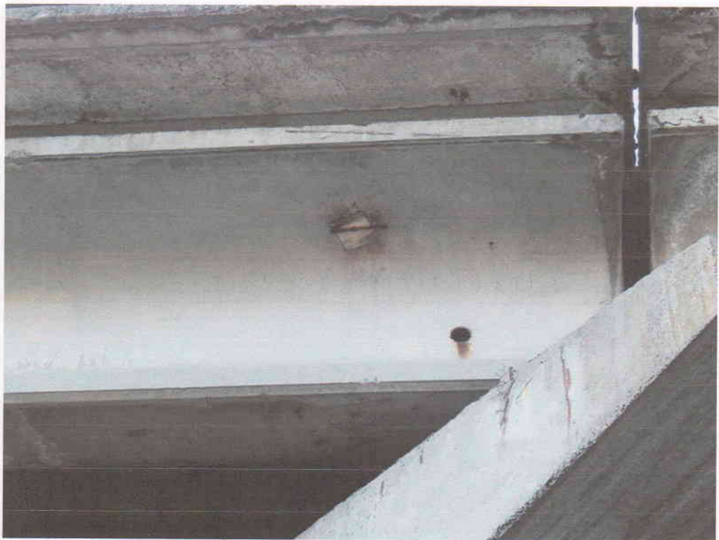
Рис. В.1.52 – Балка А в осі 6, вид К-А
