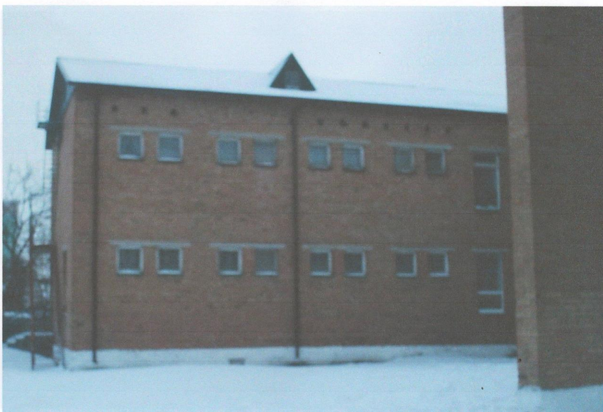
Фото 3 - Загальний вигляд будівлі по осі Г в осях 18-15
