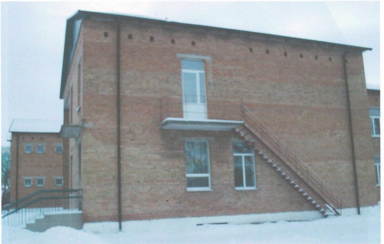
Фото 4 – Загальний вигляд будівлі по осі К в осях 17-14
