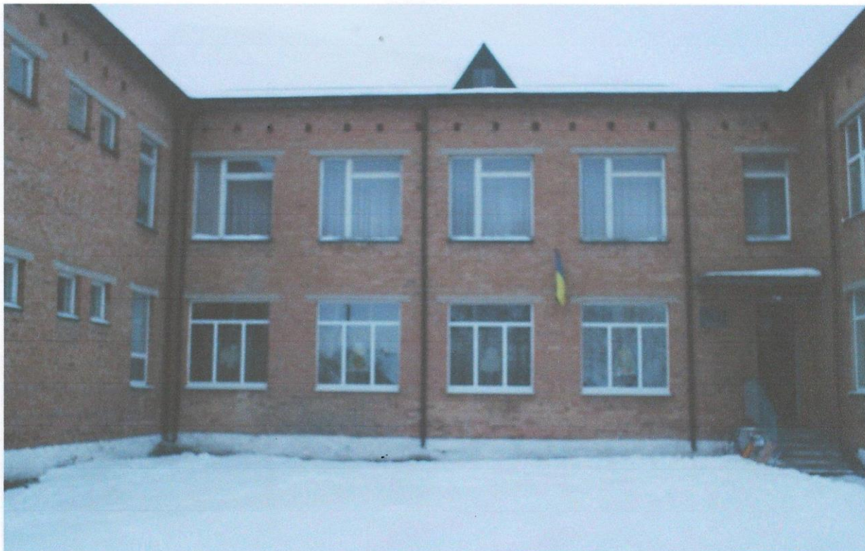
Фото 2 - Загальний вигляд будівлі по осі 15 в осях Г-Е
