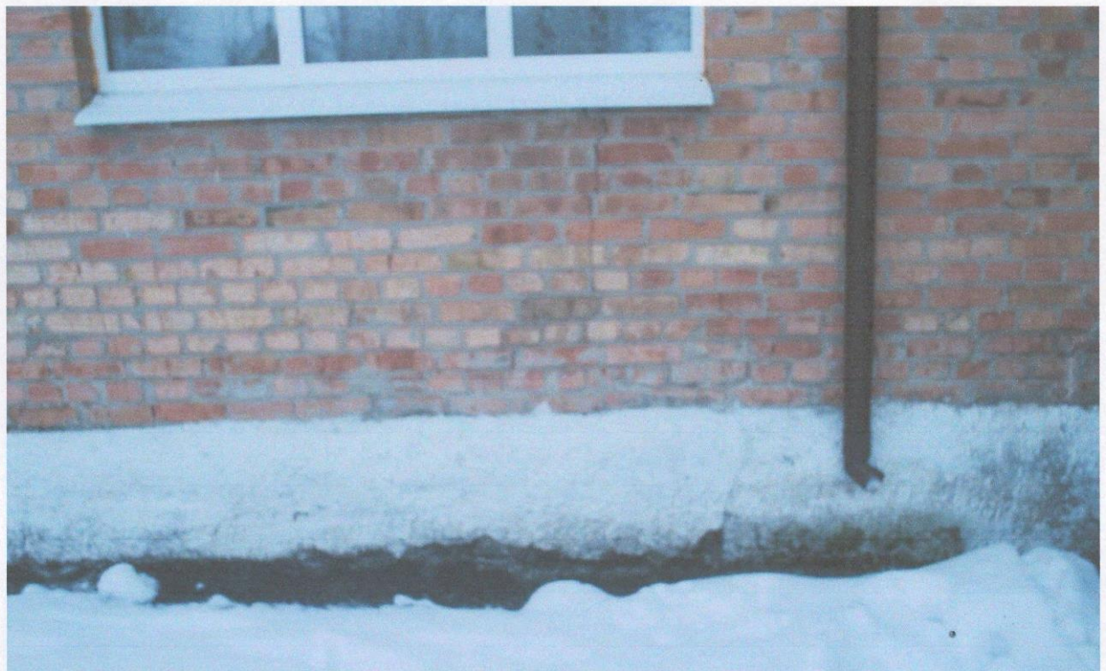
Фото А.5 – Тріщини між асфальтобетонною відмосткою та цоколем стіни по осі 15 в осях Г-Е, просідання відмостки в результаті замочування через недостатній виліт водостічних труб та неправильну організацію рельєфу
