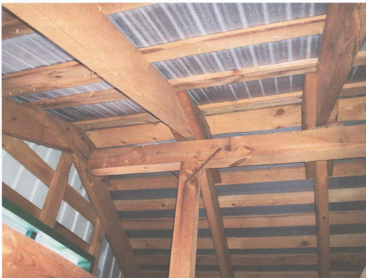
Фото 6 - Загальний вигляд конструкції даху
