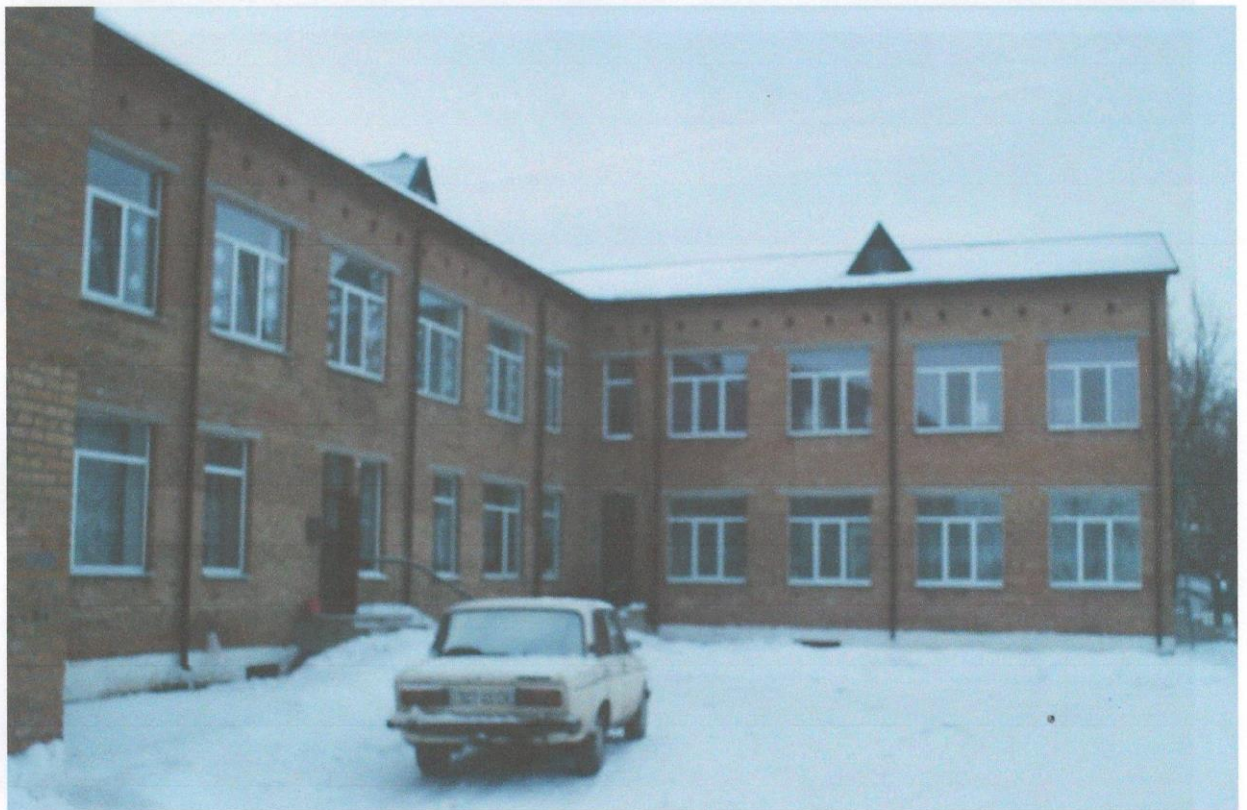
Фото 5 – Загальний вигляд будівлі зі сторони осей И і 7
