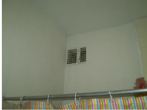
Вентиляційна решітка в санвузлі
