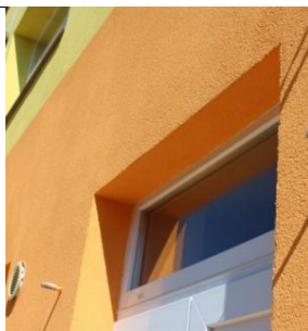
Зразок облаштування зовнішніх відкосів
