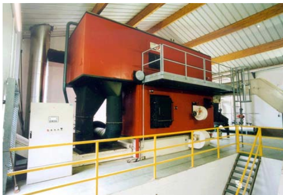
Рис. 23. Мультициклонний фільтр для очистки димових газів
