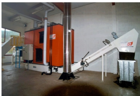
Рис. 21. Видалення золи за допомогою транспортера (вологе)
