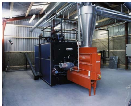
Рис. 14. Котел та система подачі біопалива
