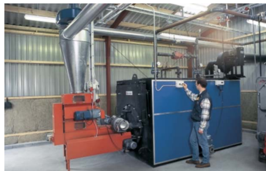
Рис. 14. Котел та система подачі біопалива
