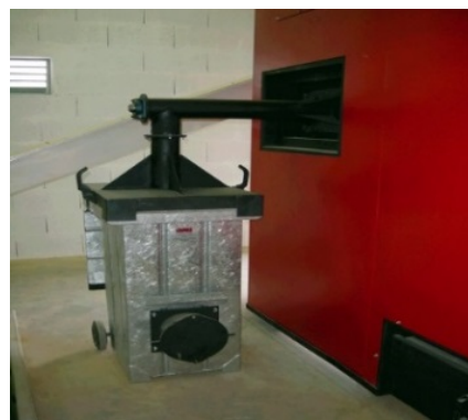
Рис. 22. Видалення золи за допомогою шнека (сухе)
