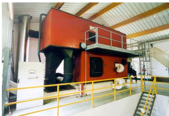
Рис. 54. Мультициклонний фільтр для очистки димових газів.
