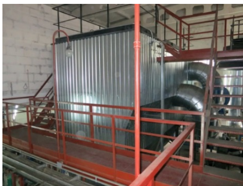
Рис. 47. Очистка димових газів
