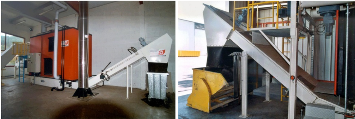
Рис. 52. Видалення золи за допомогою транспортера (вологе)
