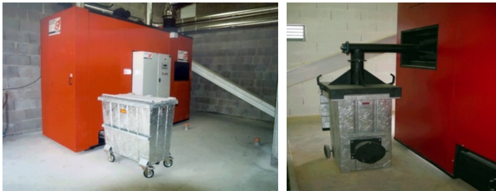
Рис. 53. Видалення золи за допомогою шнека (сухе)
