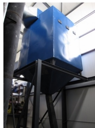
Рис. 72. Мультициклонний фільтр для очистки димових газів
