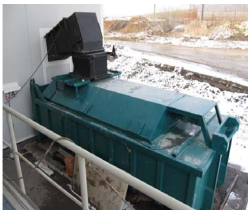
Рис. 71. Видалення золи до герметичного контейнеру
