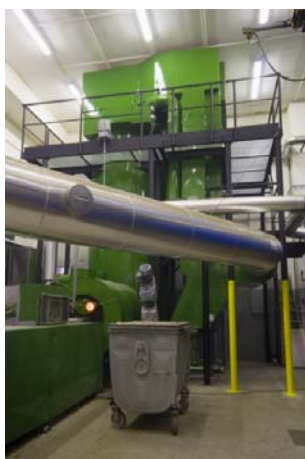
Рис. 63. Видалення золи до герметичного контейнеру
