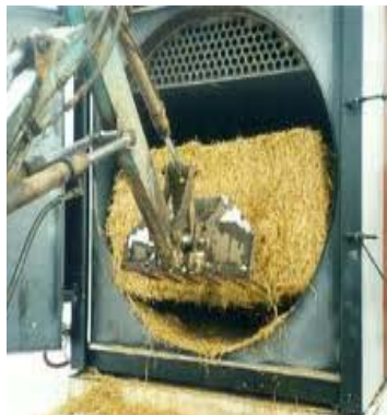
Рис. 16. Твердопаливний біокотел з можливістю механічного завантаження біопалива
