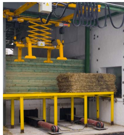
Рис. 56. Система подачі палива у котел
